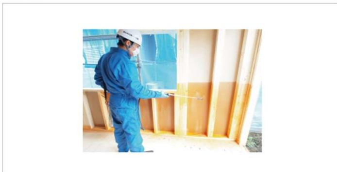
上棟した後に床から高さ1mの範囲に防蟻処理を施しております。耐久性を高めるための防腐材と同時に施工します。
