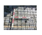
コンクリート打設前の内部配筋の 鉄筋寸法や施工状況を検査します。
