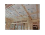
断熱材の種類や厚さ施工箇所等の 施工状況を検査します。
