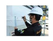
防水材の重ね長さや防水の立ち上がり高さ等の施工状況を検査します。
