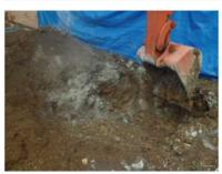
地層の土とセメント系固化材を混合 撹拌し、固化させることで地盤強化 と沈下抑制を図る工法です。地表面 から深い部分の補強に適しています。
