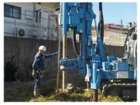
地中にセメントの柱を造って土の密度をあげていきます。もっとも一般的に多く使われている工法です。 ※六価クロム対応型のセメントを使用しております。
